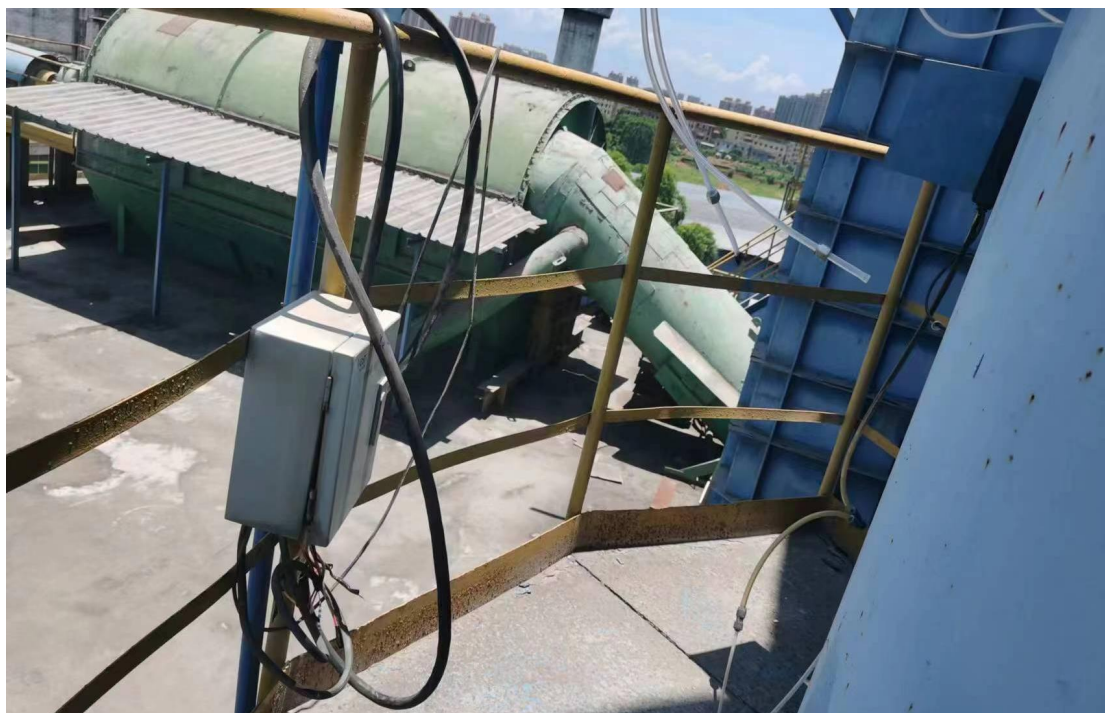
(温压仪拆除现场)
