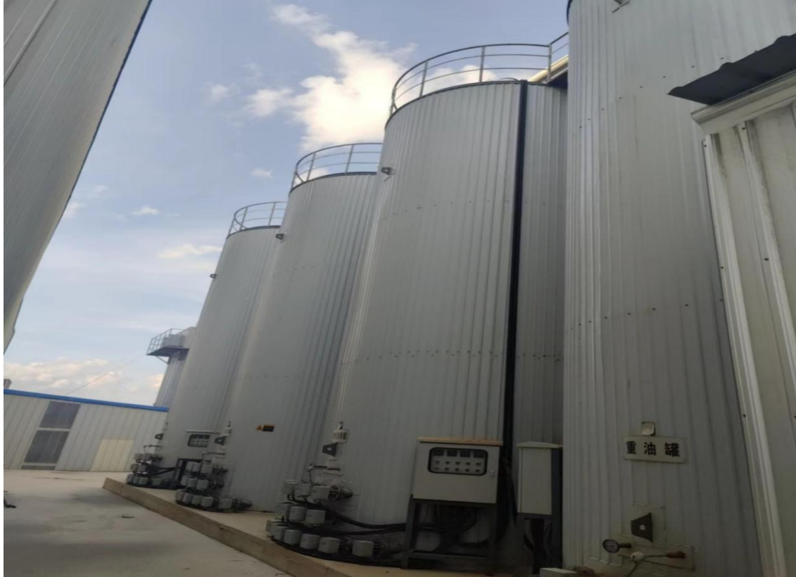
(项目建设现场情况)
