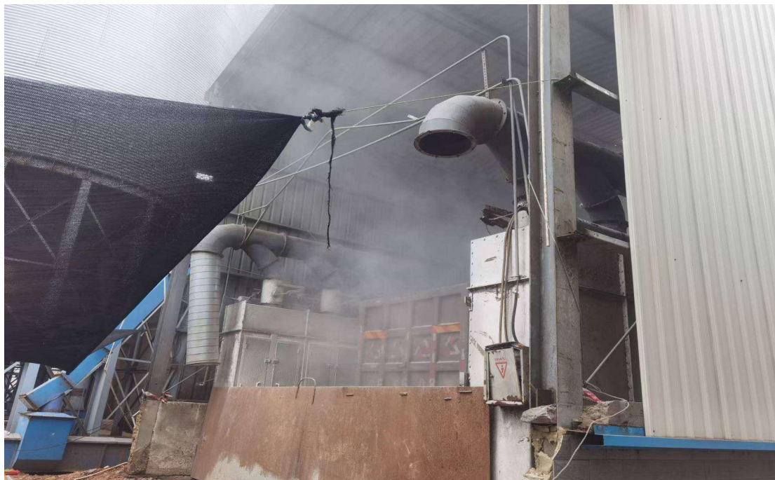
(除尘器拆除现场情况)
