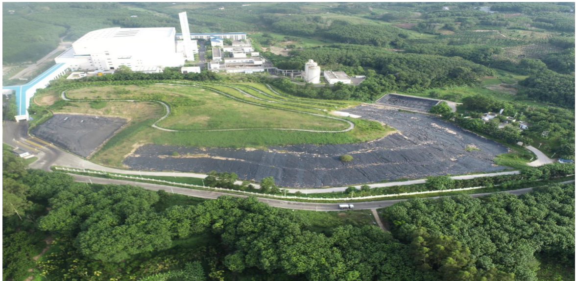
(垃圾填埋场航拍图)
