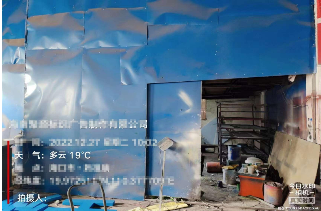
(某广告公司喷漆房)
